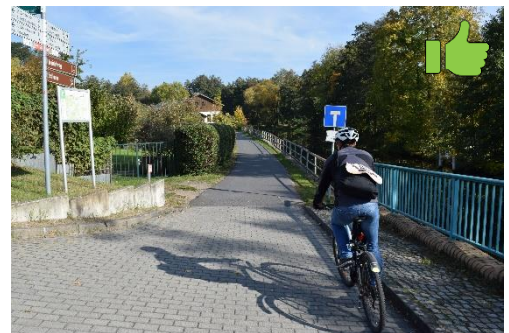
Abbildung 34: Geh- und Radweg Finowkanal Drahthammer Schleuse
