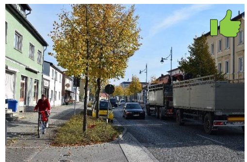
Abbildung 36: Aufpflasterung in Eberswalder Straße
